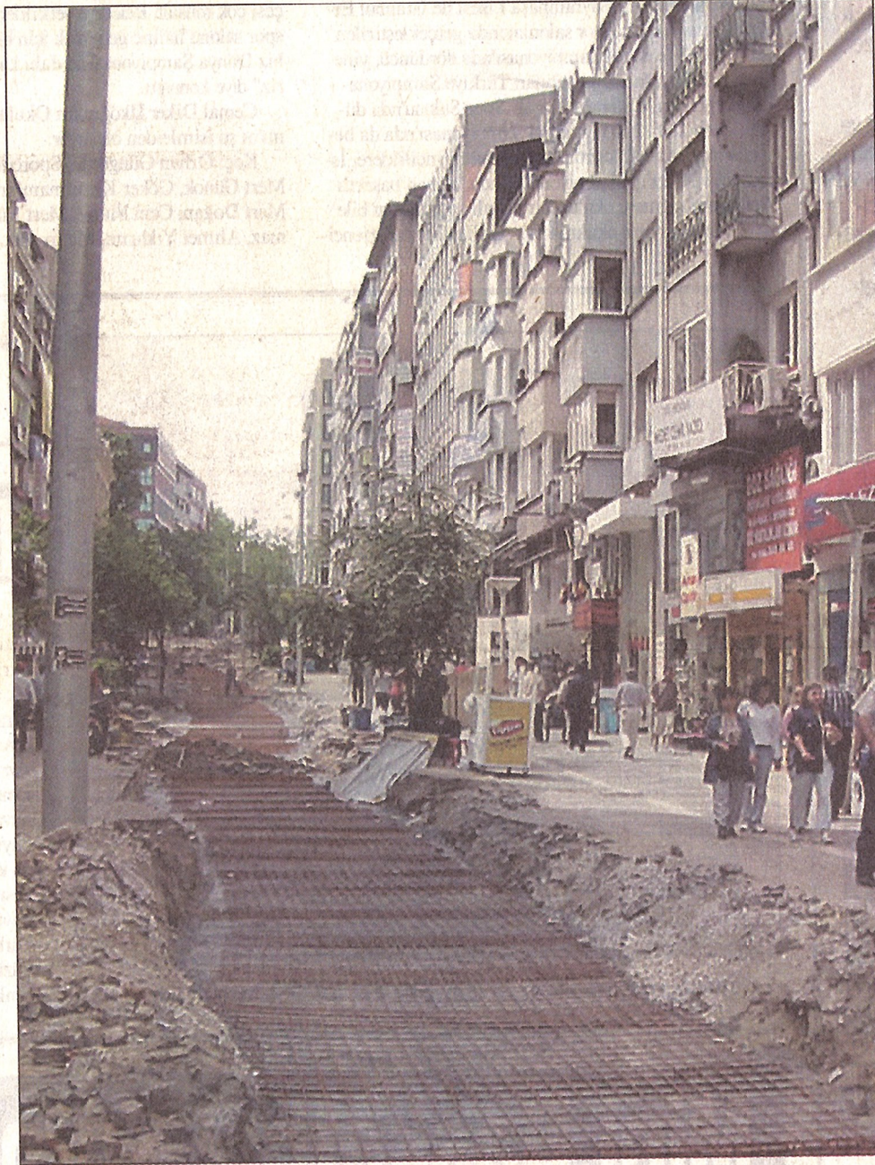
Bahariye Caddesi'nde tramvay inşaatı hızla devam ediyor....
